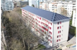
Liestalerstrasse, Basel © Solvatec - ( Bild in hoher Auflösung )
